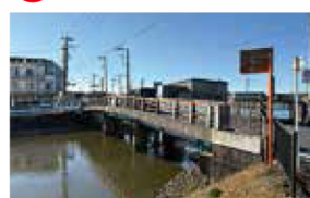
橋梁補修工事
