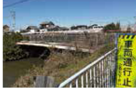
橋梁架換工事等
