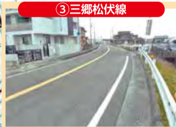
3 三郷松伏線 市道に移管するための補修工事・台帳整備委託
