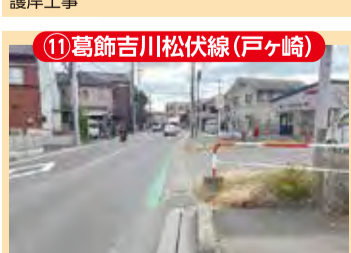
11 葛飾吉川松伏線(戸ヶ崎) 歩道整備工事
