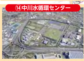
14 中川水循環センター 自家発電機コントローラー改築工事・汚泥処理施設基本設計業務委託等
