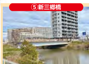
5 新三郷橋 塗替え塗装工事・測量設計
