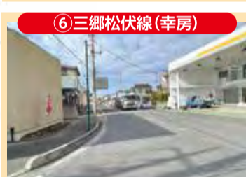
6 三郷松伏線(幸房) 舗装修繕(切削オーバーレイ)
