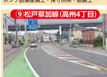
9 松戸草加線(高州4丁目) 舗装修繕(切削オーバーレイ)
