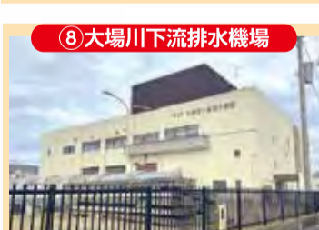
8 大場川下流排水機場 ポンプ設備整備工・保守点検・耐震工
