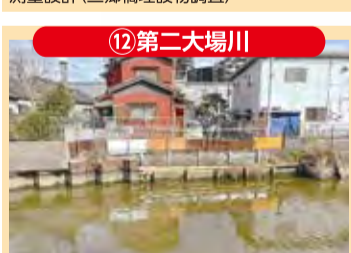
12 第二大場川 護岸工事
