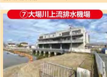
7 大場川上流排水機場 保守点検・耐震工、調節池・排水機場増強検討
