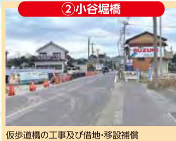
2 小谷堀橋 仮歩道橋の工事及び借地・移設補償
