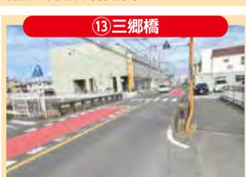
13 三郷橋 測量設計(三郷橋埋設物調査)
