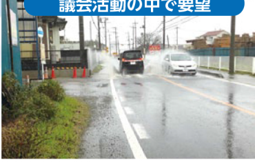
越谷流山線の側溝新設
