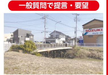
小谷堀橋架け替えに伴う借地使用料・迂回路工事・用地買収・物件補償・架け替え工事
