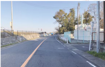
葛飾吉川松伏線(上口付近)の舗装修繕
