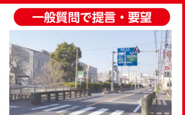
三郷橋架け替えに伴う測量設計・物件調査・用地補償
