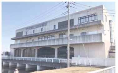
大場川上流排水機場の躯体の耐震化工事・ポンプ設備整備工事・保守点検
