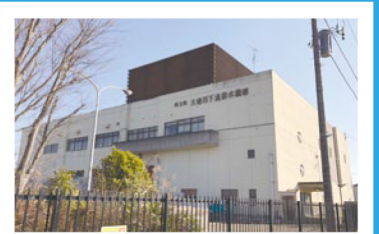
大場川下流排水機場のポンプ増設工事等 台風や大雨時に大場川の水を江戸川に排水し、大場川の水位を低く保つことで、特に放水路以南の地域の冠水対策を実施する。現在まで毎秒20m 3 の排水量を、毎秒35m 3 に増強することで浸水エリアを減少させる。令和4年度出水期までに事業完了予定。
