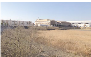
新和小学校北側調節地の樹木伐採
